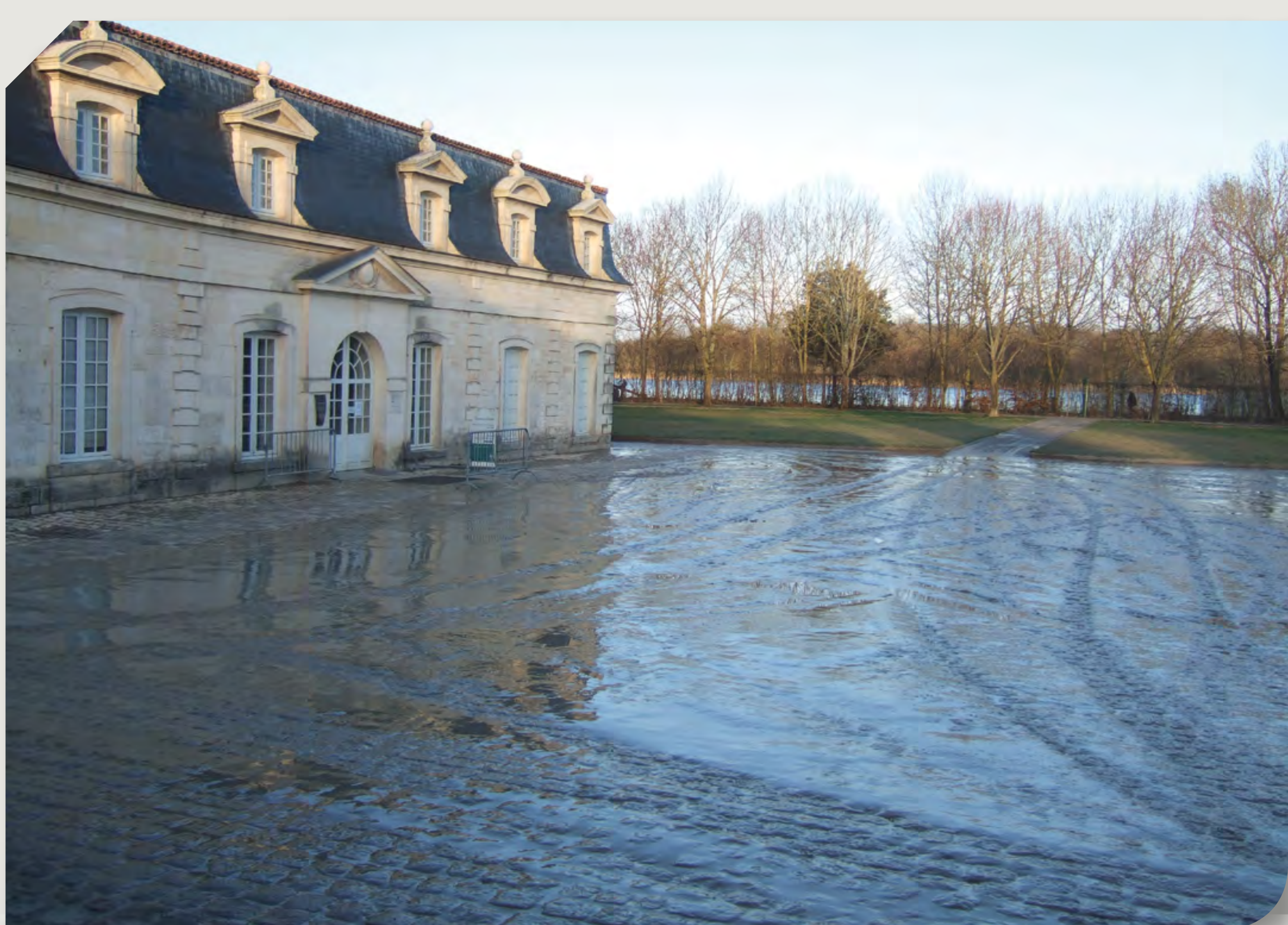
Rochefort - février 2010. L'eau se retire de la Corderie Royale après le passage de la tempête Xynthia. © Ville de Rochefort
